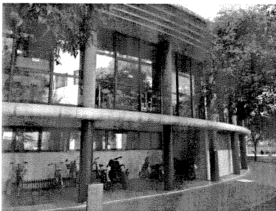
Foto n°2 – particolare dell’edificio parte porticata a Est
