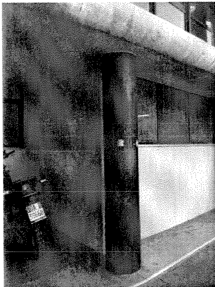
Foto n°3 – angolo dell'edificio – sul muro cieco del porticato è prevista la realizzazione del nuovo ingresso diretto alla cucina
