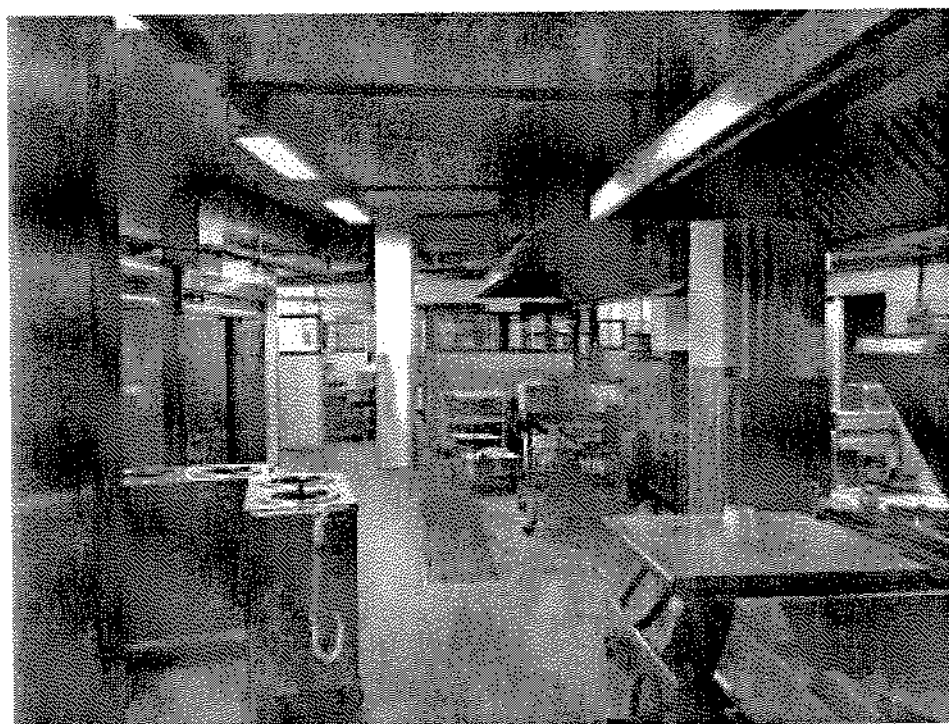
Foto n°8 - ripresa interna - cucina
