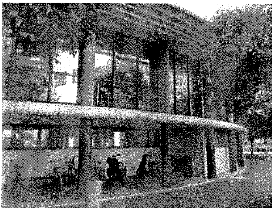
Foto n°2 – particolare dell’edificio parte porticata a Est
